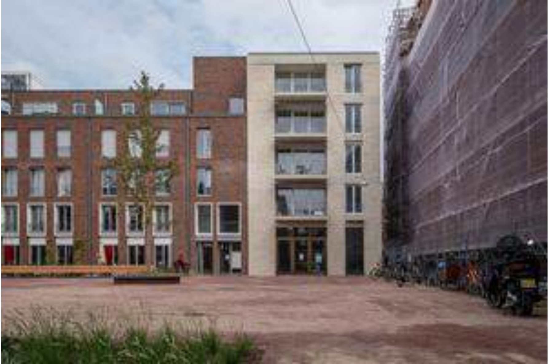
CC Amstel, het nieuwe theater aan het Cullinaplein in de Pijp © Rink Hof
